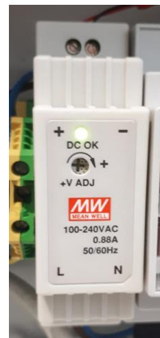
Annexe 44 : Bornes de raccordement et alimentaiton 230V / 5V
