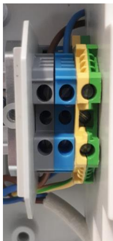
Annexe 44 : Bornes de raccordement et alimentaiton 230V / 5V
