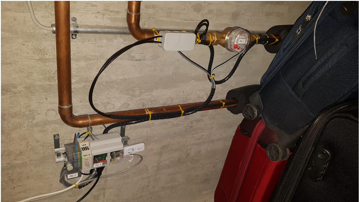
Figure 25 : Raspberry Pi et compteur de débit.
