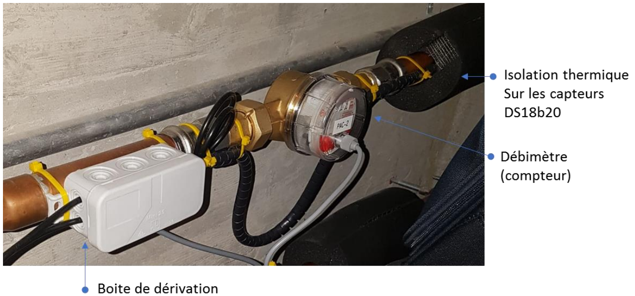
Figure 22 : Compteur à impulsions pour déterminer le débit d'eau.
